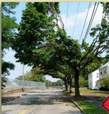
Paradossale mancato rispetto delle distanze di legge al di sotto delle reti elettriche
